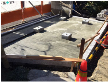
基礎工事終了
