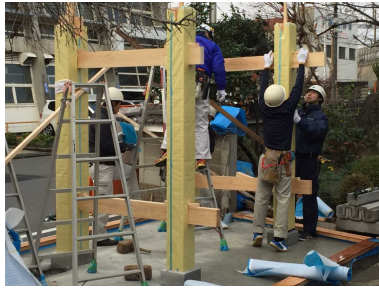
棟上げ当日 組み立て開始
